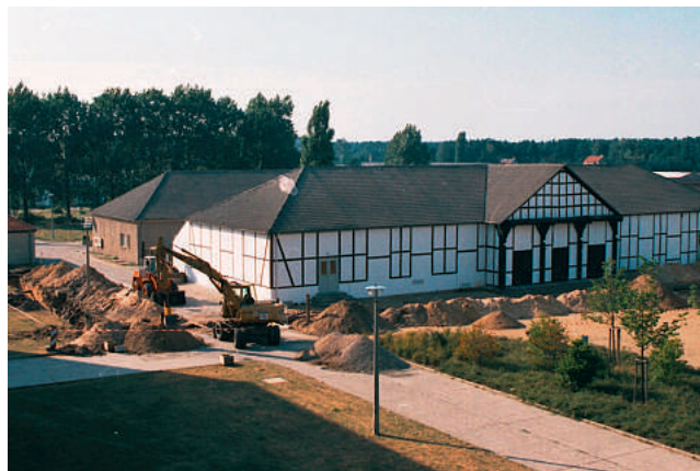
Ca. 30 Mio. Euro wurden bis 2006 in Basdorf investiert
