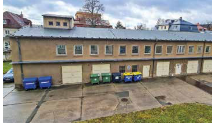
Das Haus 3 wird abgerissen.
