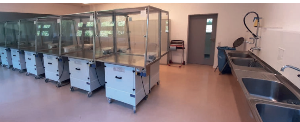
Laborraum für die Spurensicherung, in dem sich 14 Arbeitstische mit Feinstaubabsaugung sowie Doppelmehrzweckbecken mit Spülbrausegaritur befinden.
