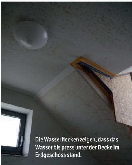
Die Wasserflecken zeigen, dass das Wasser bis press unter der Decke im Erdgeschoss stand.
