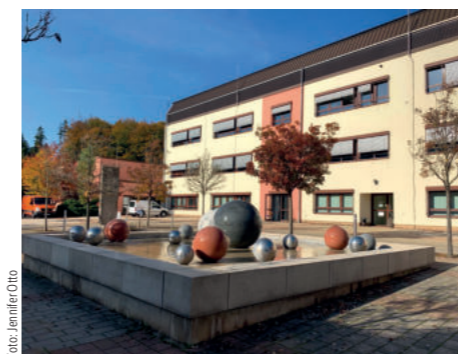
Hörsaalgebäude an der HdP
