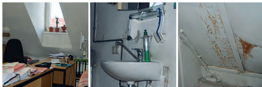
Weitere Baustellen warten auf uns.
