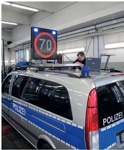
Aufbau und Reparatur der WeniPol-Anlagen.
