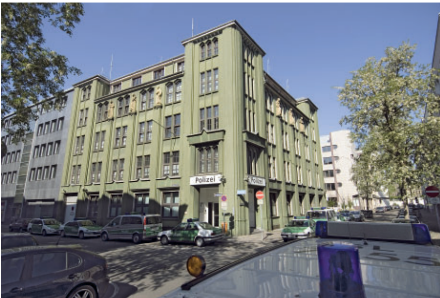
Die Polizeibezirksinspektion Saarbrücken St. Johann ist die größte Polizeiinspektion im Saarland. Sie ist zuständig für den Innenstadtbereich der Landeshauptstadt. Insgesamt verrichten dort rund 140 Kolleginnen und Kollegen Schichtdienst. Foto: Ralf Porzel
