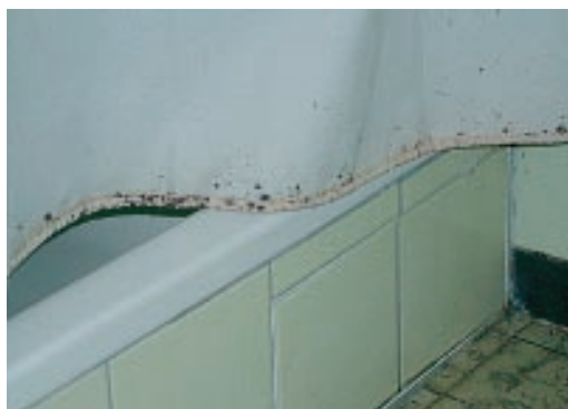
Detail des Duschraumes im Kellergeschoss
