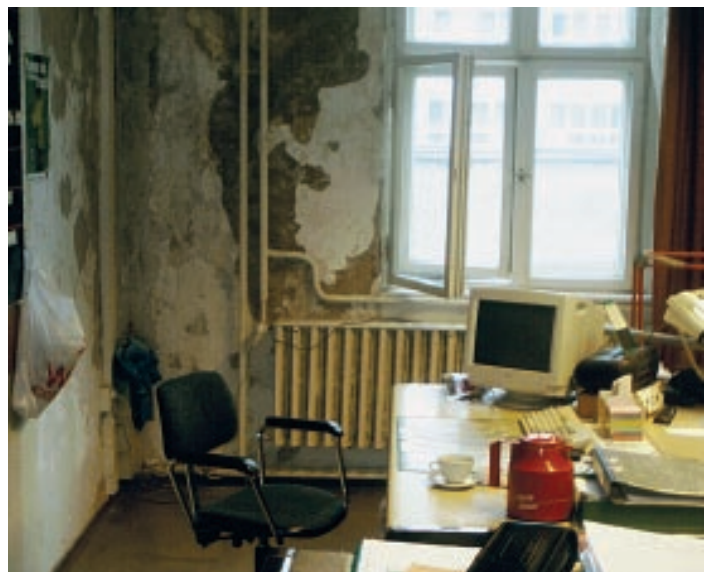
Der Putz wurde als „erste Hilfe“ entfernt, die Feuchtigkeit kann nun ungehindert abfließen. Wann der Zustand geändert wird, steht in den Sternen. Der Personalrat drängelt. DP wird berichten.
