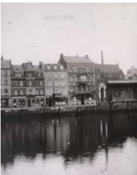
WSP Kiel, Wall 42, mit Balkon und Empore
