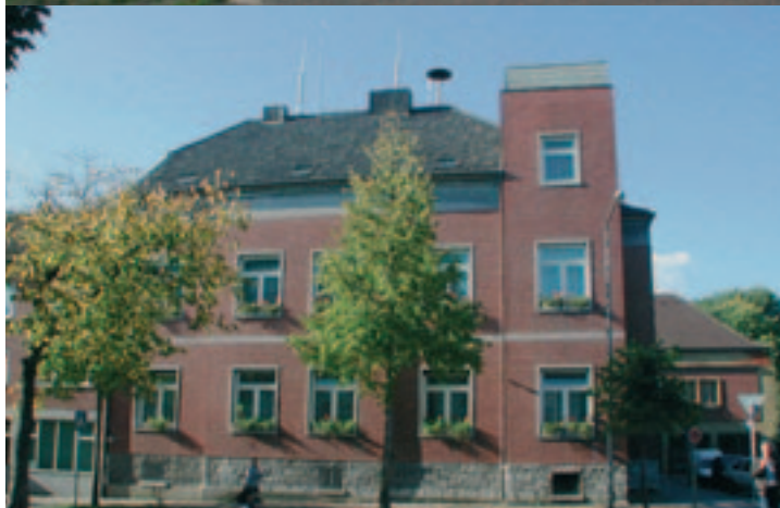
Antennenanlage auf einem öffentlichen Gebäude, in dem sich eine Sende- und Empfangsstation (Basisstation) befindet
