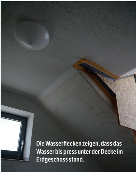
Die Wasserflecken zeigen, dass das Wasser bis press unter der Decke im Erdgeschoss stand.
