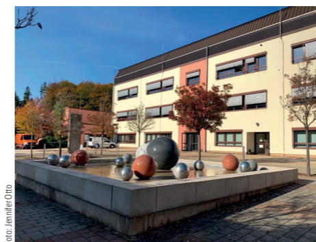
Hörsaalgebäude an der HdP
